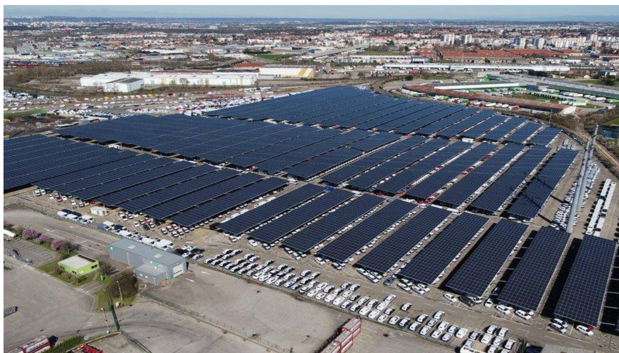
Рис.5. Автостоянка с энергетическими навесами в г. Корбас
